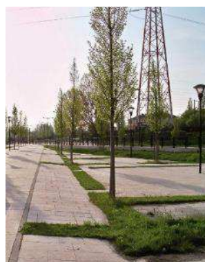
Tranchée drainante au bord de la RD28 en Seine-Saint-Denis (source : Composante Urbaine)
