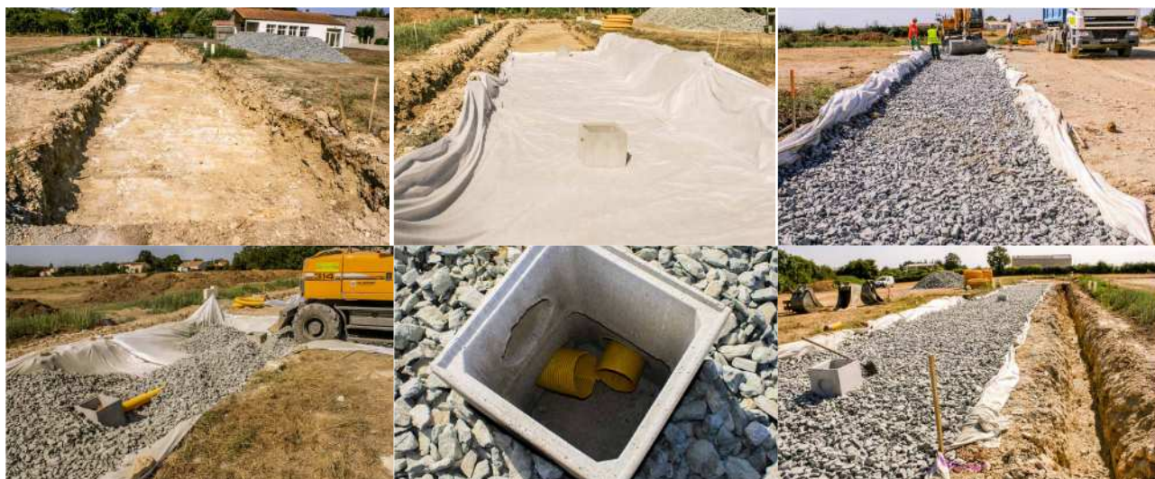
Mise en place d'une chaussée à structure réservoir dans l'écoquartier des Ecluzis à Oulmes (85) (in http://les-ecluzis.fr/actualites/aout-2012-mise-en-place-des-chaussees-reservoirs )
