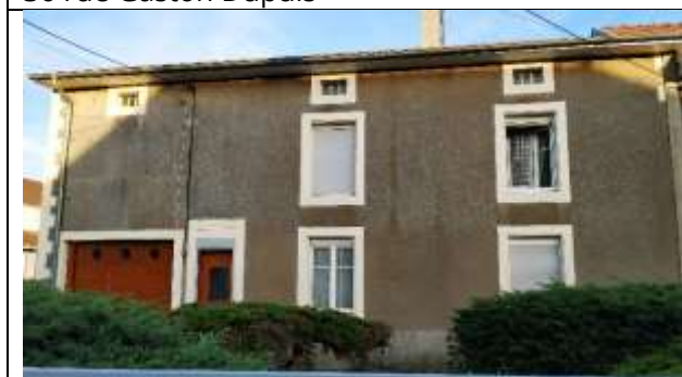
31 : Maison avec linteau (1852) située au 45 rue Gaston Dupuis
