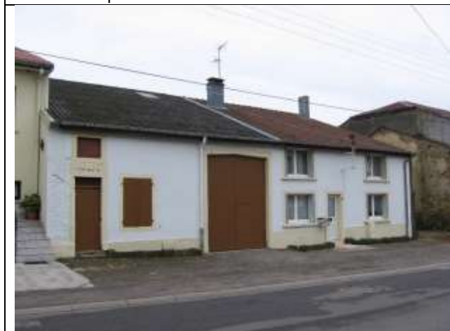
33 : Maison avec linteau (1883) située au 83 rue Gaston Dupuis
