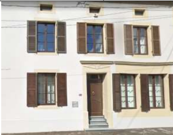
22 : Maison avec linteau (1858) située au 120 rue Emile Curicque
