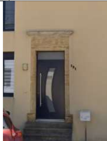
23 : Maison avec linteau (1836) située au 121 rue Emile Curicque
