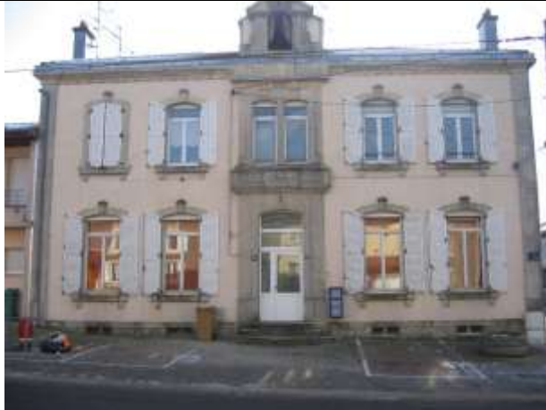
16 : Ancienne école des filles avec linteau (1898) située au 77 rue Emile Curicque
