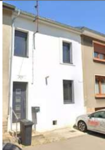
21 : Maison avec linteau (1717) située au 104 rue Emile Curicque
