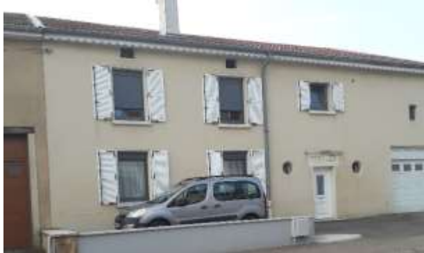
14 : Maison avec linteau (1831) située au 64 rue Emile Curicque
