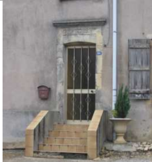
19 : Maison avec linteau (1767) située au 86 rue Emile Curicque
