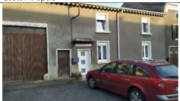
32 : Maison avec linteau (1823) située au 49 rue Gaston Dupuis
