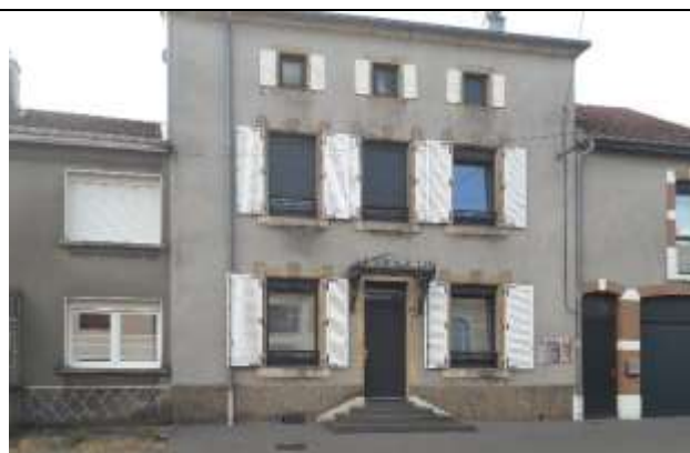
7 : Maison avec linteau (1819) située au 10 rue Emile Curicque
