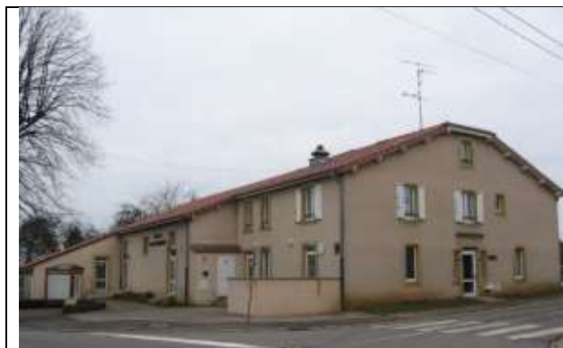
29 : Salle polyvalente avec linteau (1821) située au 36 rue Gaston Dupuis
