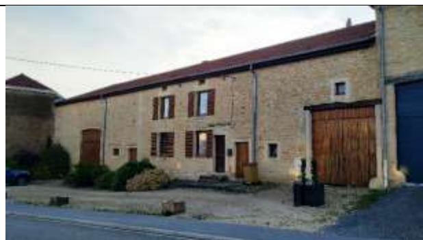
30 : Maison avec linteau (1825) située au 44 rue Gaston Dupuis
