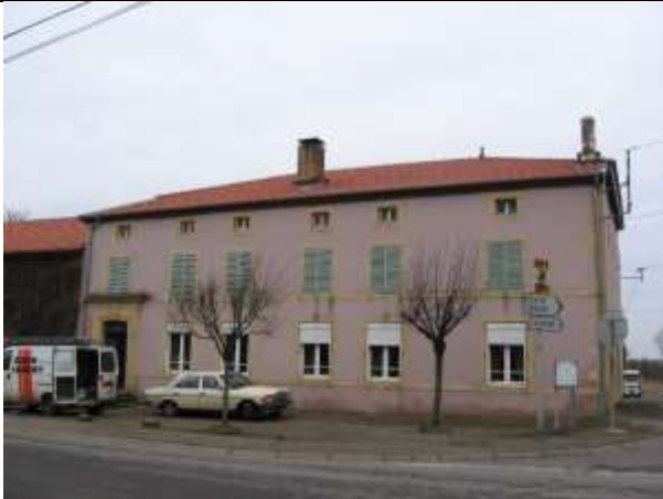
26 : Ancienne maison située au 132 rue Emile Curicque
