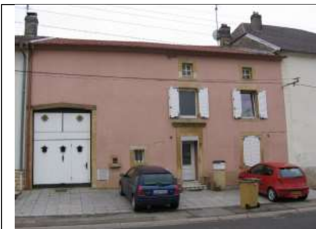
35 : Maison avec linteau (1852) située au 95 rue Gaston Dupuis
