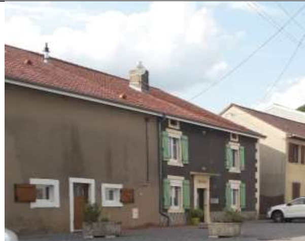
28 : Maison avec linteau (1826) située au 142 rue Emile Curicque
