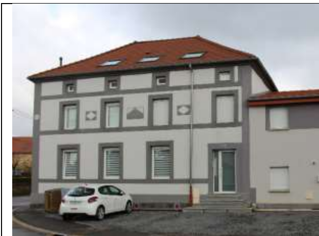
41 : Maison avec linteau (1854) située au 122 rue Gaston Dupuis
