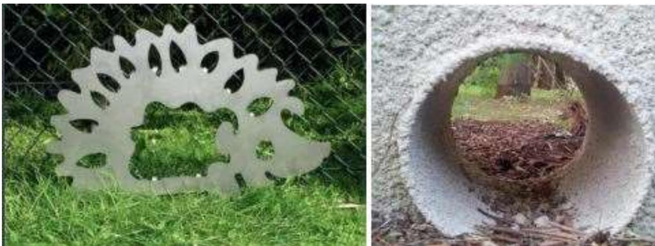
Deux exemples de passage pour la petite faune, Source : Les fiches techniques « Limiter l'impact des clôtures sur la biodiversité » U2B
